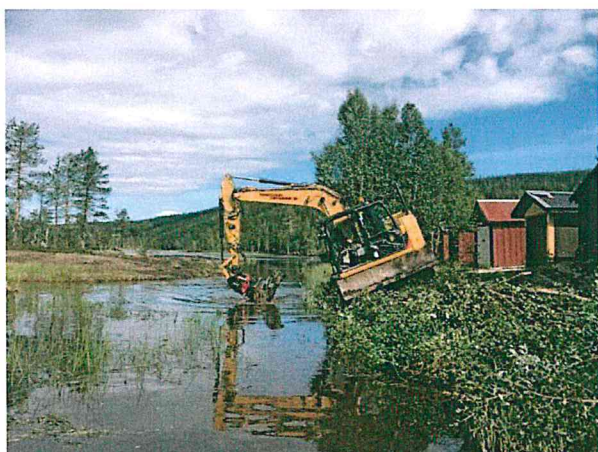
Til utgraving av kanalen ble det brukt gravemaskin.
